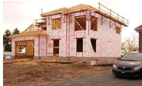
*L'épaisseur des panneaux peut être coupée sur mesure pour des projets sur mesure.*
