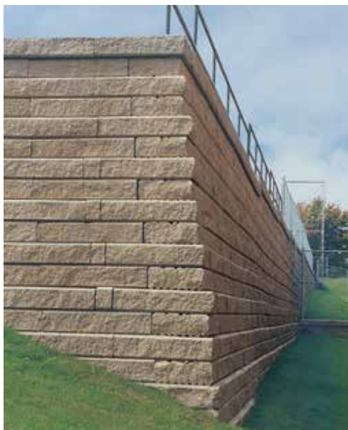
Le recours à des géogrilles permet de gagner en hauteur et minimiser les coûts de construction.
