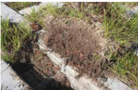
Pour des pavages végétalisés subissant des passages véhiculaires importants, un terreau structurant est recommandé dans le but de réduire le tassement des alvéoles végétalisées.
