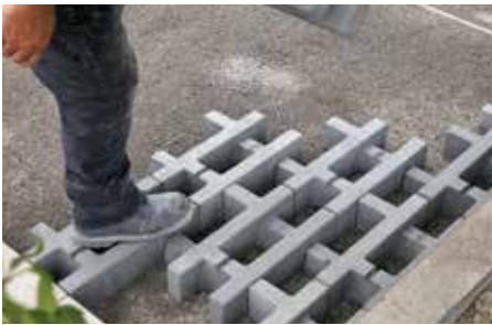
Les pavés Boulevard Verde se posent en lisières sur une fondation granulaire conventionnelle densifiée.
