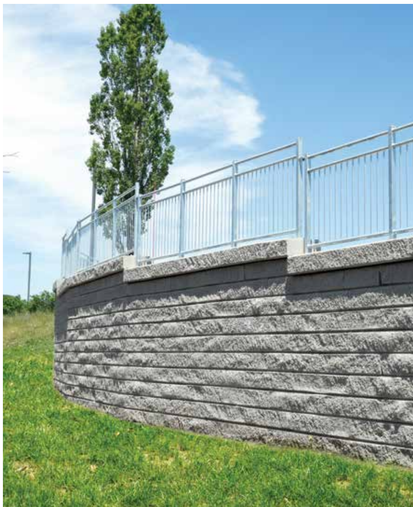
Construction de murs de grande envergure en ligne droite et même en courbe.
