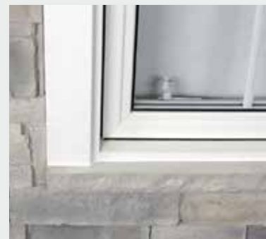
Finition avec allège de fenêtre, moulure et jambage
